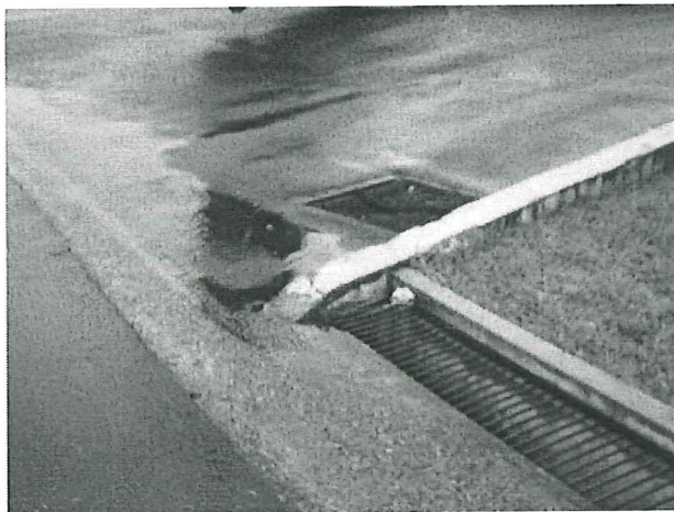
Bordillo en donde impactó la aeronave.
